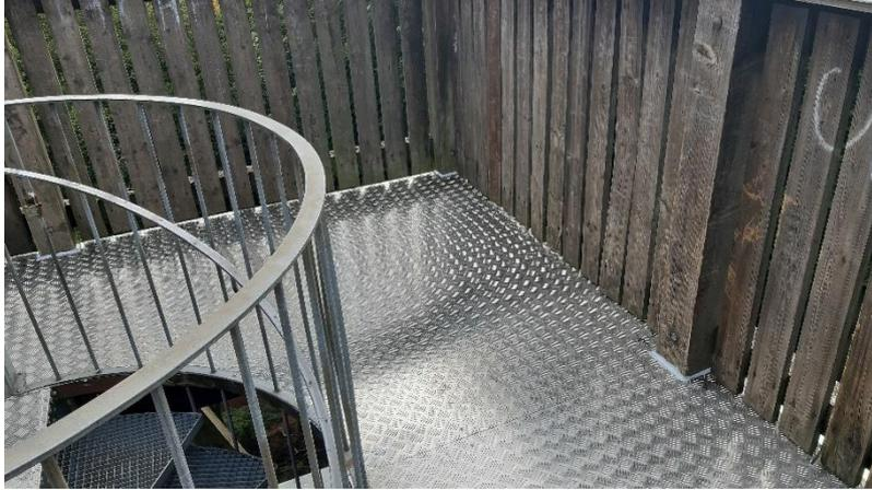
Holzaufbau durch den Wassereinfluss bei Regen und Schnee immer mehr Schäden genommen hat. Einige Holzbalken und auch Holzbohlen wurden erneuert. Um das Holz langfristig zu schützen, wurde nach einer Lösung gesucht. Die Wahl fiel auf die Installation eines Metallbodens auf den beiden Ebenen des Holzaufbaus, damit das Wasser komplett nach außen abläuft. In diesen Tagen wird die Installation des Bodens
